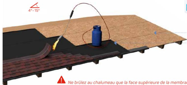
**⚠ Ne brûlez au chalumeau que la face supérieure de la membrane et collez les bardeaux sur l'Armourbase Thermo AD activé. Ne brûlez pas les bardeaux au chalumeau !**
