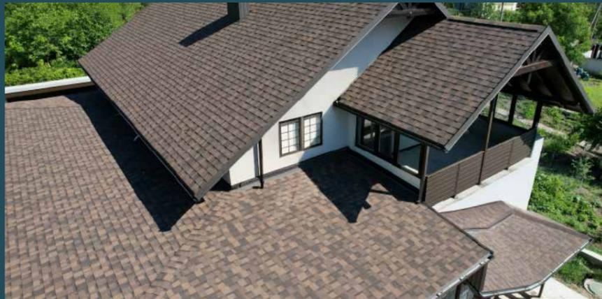
IKO a encore amélioré la fiabilité de ses bardeaux de toiture de la plus haute qualité avec le nouveau Shingle 2.0. Les bardeaux de toiture IKO se composent de **matières premières européennes locales** et soigneusement sélectionnées, d'une couche de fibre de verre, de bitume et d'une couche de finition en granules de pierre naturelle, disponibles dans une variété de couleurs. Nous avons perfectionné notre fabrication pour produire des bardeaux de qualité.
