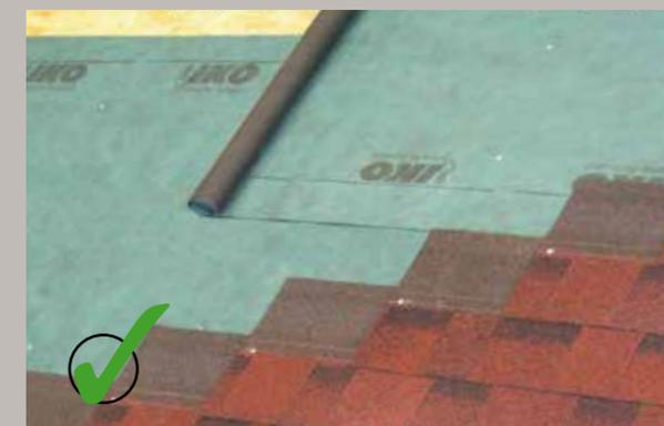
Schadhaftes Holz ist zu ersetzen. Vorzugsweise verwenden Sie bei flacheren Dachneigungen OSB Platten. Die anschließende Eindeckung erfolgt mit Armourbase Vordeckbahnen und Cambridge Xtreme 9,5°.
