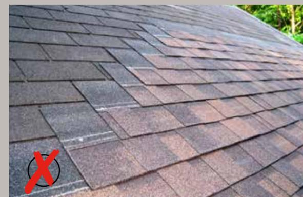
Verlegen Sie nicht im Schindel auf Schindel Verfahren. Reißen Sie die alten Schindeln ab und beginnen Sie mit der Verlegung ab der Unterkonstruktion.
